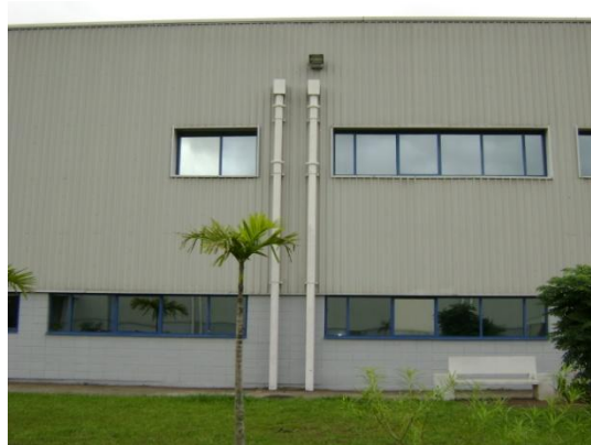
Figura 2 - Fachada lateral dos prédios de galpão com o padrão de drenagem adotado.
